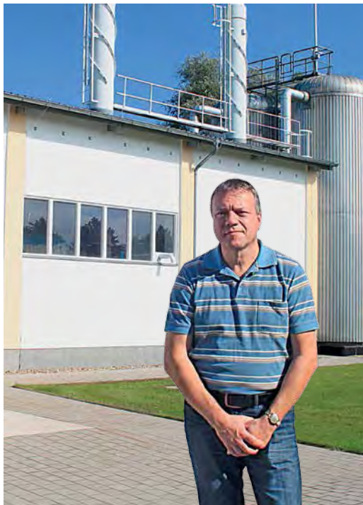
Links: In dieser BHKW-Anlage im Kirchhofsweg 6 in Luckenwalde werden effizient gleichzeitig Strom und Wärme erzeugt und in die Netze eingespeist
